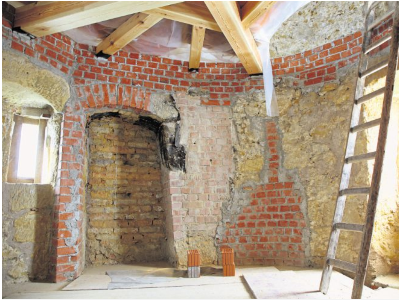
Aus diesem Raum im Mauerthurm am Henkerbergl wird ein Badezimmer.
