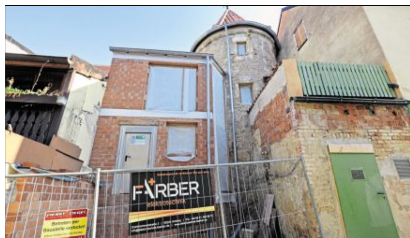
Die Arbeiten am Mauerthurm sind noch nicht abgeschlossen. Die Stadtbau Amberg will hier eine Gästewohnung bauen.
