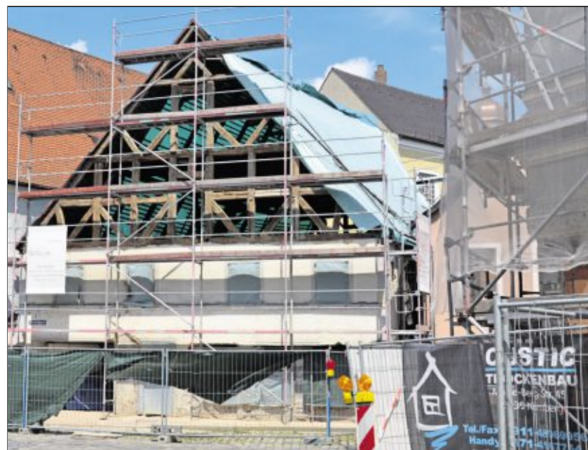
In der Amberger Altstadt werden mehrere Gebäude saniert, wie dieses Haus in der Steinhofgasse neben der Metzgerei Lindner.
