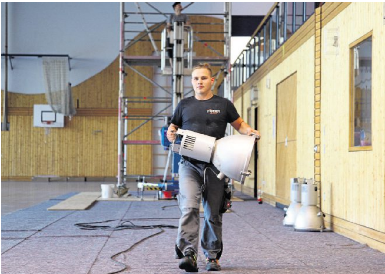
Die Stadt nutzt die Ferienzeit, um in der Trimax-Halle neue LED-Strahler montieren zu lassen. Sie sind heller als die alten Leuchten und verbrauchen deutlich weniger Strom. Bild: Steinbacher
